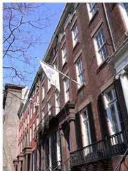
写真1. ニューヨーク大学の建物の外観
